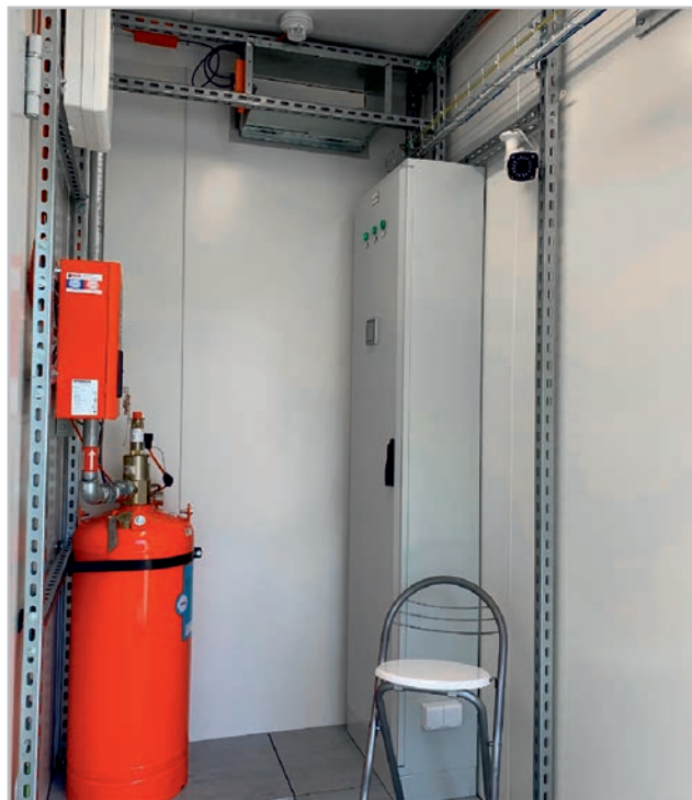
Przeźnię pomieszczenia technicznego: SUG, rozdzielnia główna kontenera wy zimnego korytarza oraz ułożenie kabli LAN
