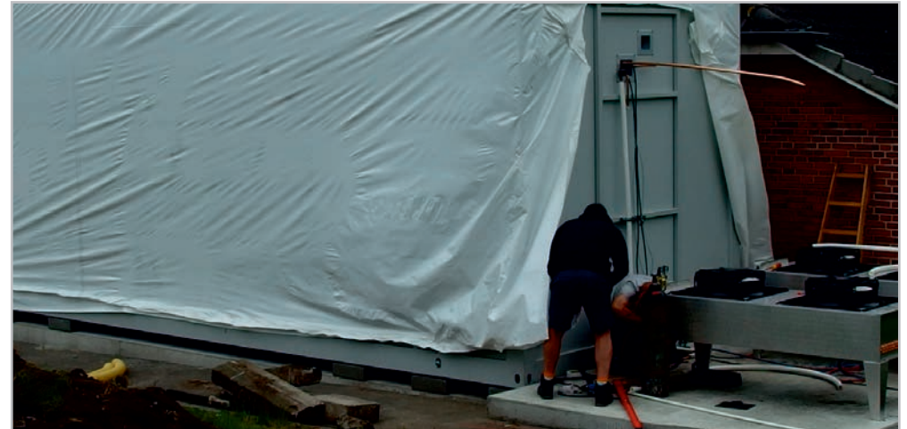
Montaż instalacji klimatyzacji (skraplacze)
