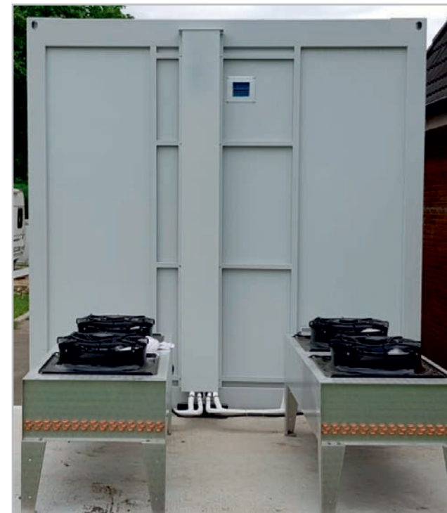
Skraplacze jednostek BKTiROW systemu DX gotowe do pracy
