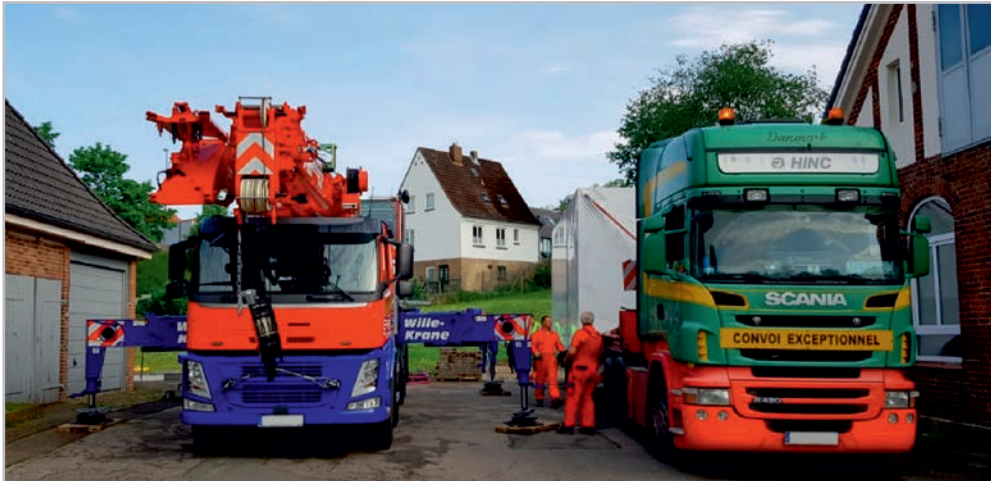
Rozładunek i ustawienie na cokole betonowym
