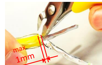
4. Usuń folię ekranu z każdej pary do wysokości 1mm od powłoki zewnętrznej za pomocą szcypiec tnących.
