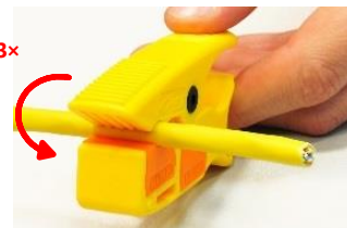
2. Usuń osłonkę zewnętrzną 50mm przy użyciu strippera BKT.
